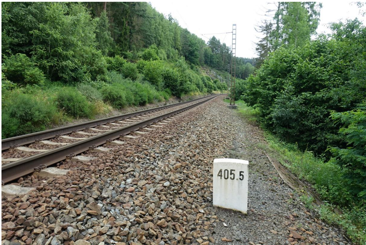
Foto 5 – Pohled zpět na inflex směrového řešení (viditelné deformace koleje – propad nivelety)
