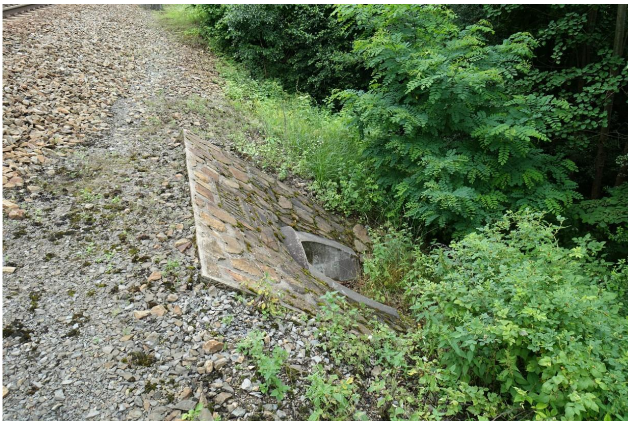
Foto 6 – Výtok propustku evid. km 405,423 vč. jeho odláždění
